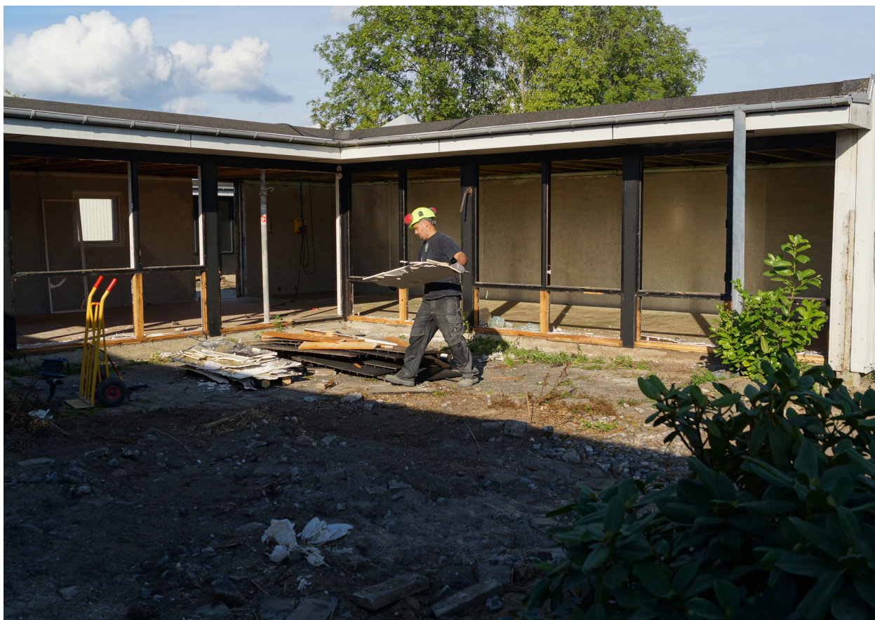
På denne eftermiddag i september, er det mest nedriverne der er på arbejde. De sørger lige nu for at det materiale der er nedbrudt fra boligen, bliver forsvarligt fjernet.
