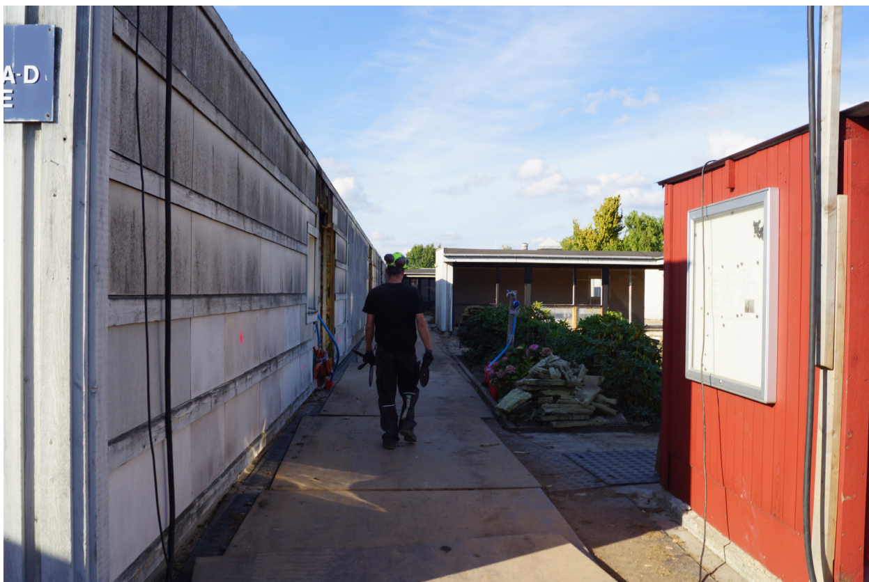
Husene der allerede har fået en tur af nedriverne, og de der stadig venter, ligger side om side.
